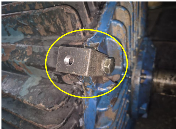
FAN COVER 고정 BLOCK 가공설치
