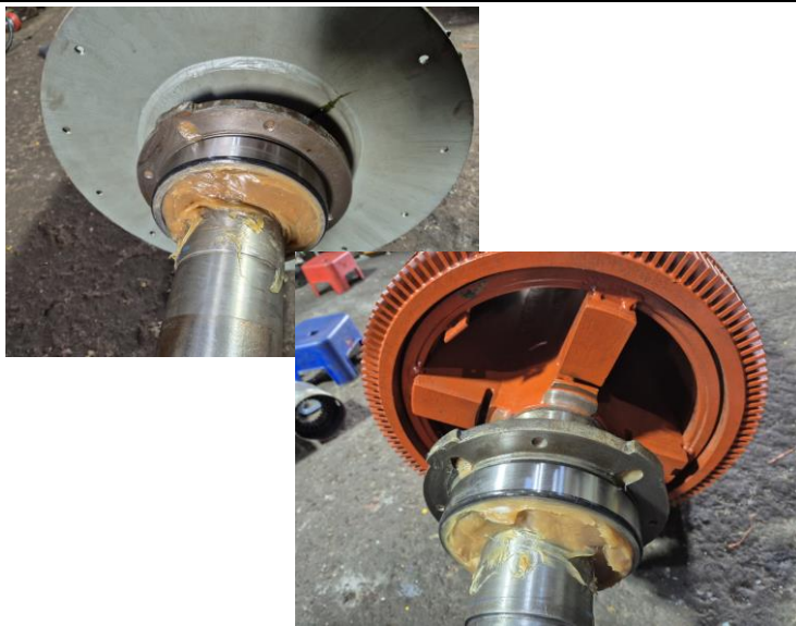
소모품 교환될 BEARING GREASE CHARGING 조립실시
