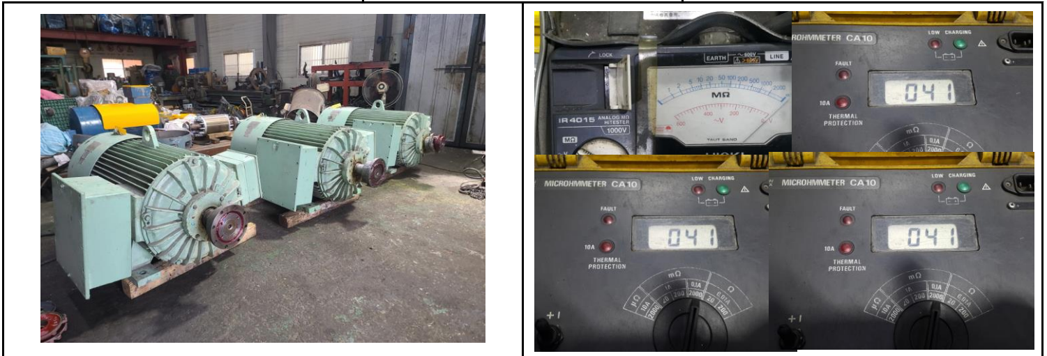
Ass'y 분해 전 입고검사 A 절연저항 & 각 상별 권선저항
