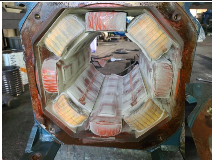
BLOWER 설치된 방향
