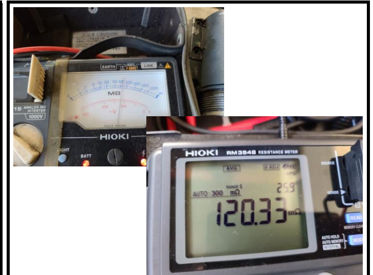
Z축 절연저항 및 각 상별 권선저항 동일
