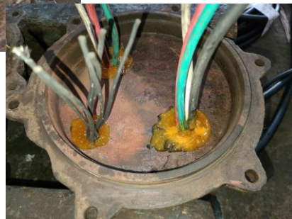
SOCKET조립 및 EPOXY MOULDING 실시
